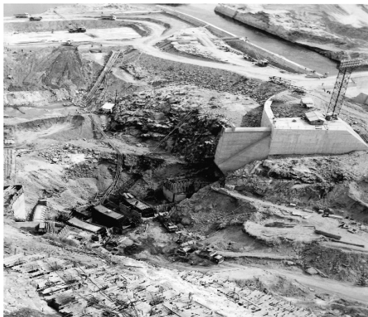
Fig. 25. Salto de Alcántara: Canal de desvío y ataguía de escollera (1966)
