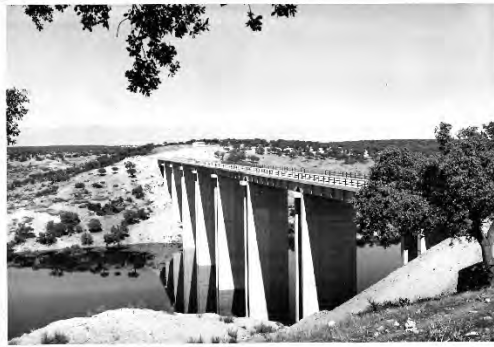
Fig. 29. Puente de Alarza (1964)
