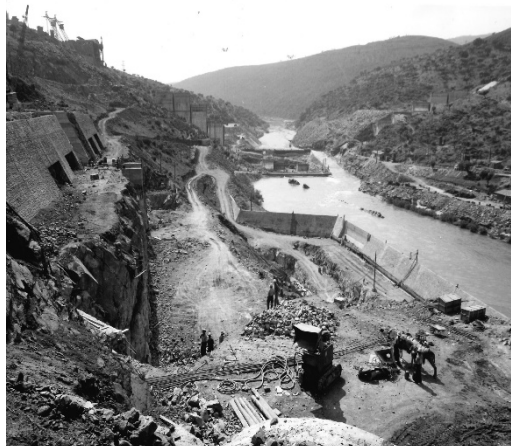
Fig. 26. Salto de Torrejón: Excavación de la presa sobre el Tajo (1962)
