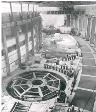
Fig. 28. Valdecañas: Montaje maquinaria de la central (1963)
