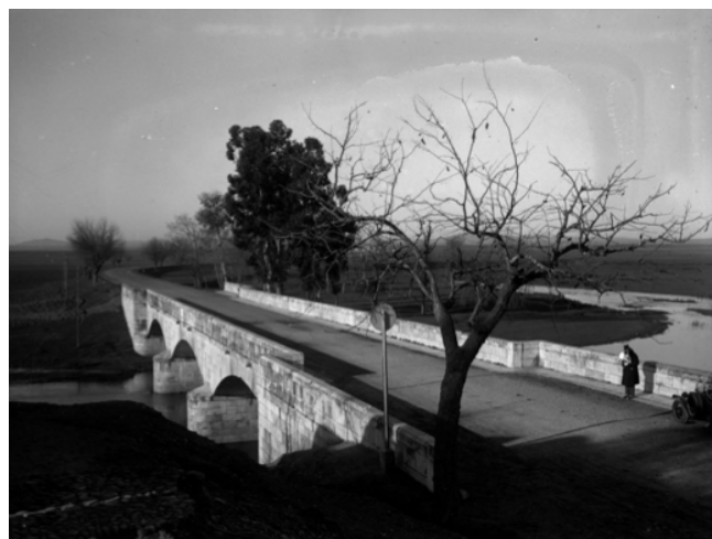
Fig. 7. Puente internacional sobre el rio Caya. Fondo Gerardo Contreras. 1928 ARCM. Signatura 000124405
