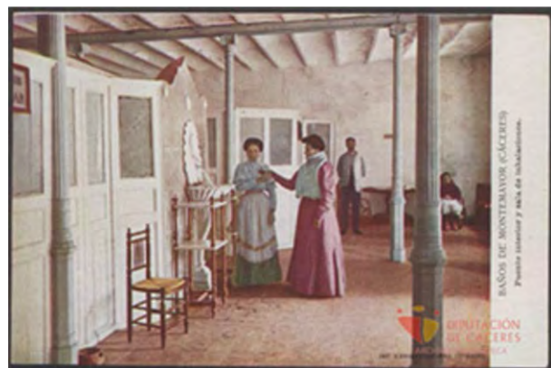
Fig. 25. Fuente interior y sala de inhalaciones del Balneario de Baños de Montemayor. ES. 10037.ADPCC / 04.02.51. // POS 00077
