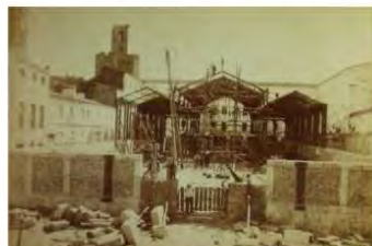
Construcción del edificio metálico en la Plaza Alta de Badajoz (1883).
