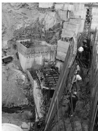
Fig. 27. Salto de Cedillo: hormigonado del bloque I (1970)
