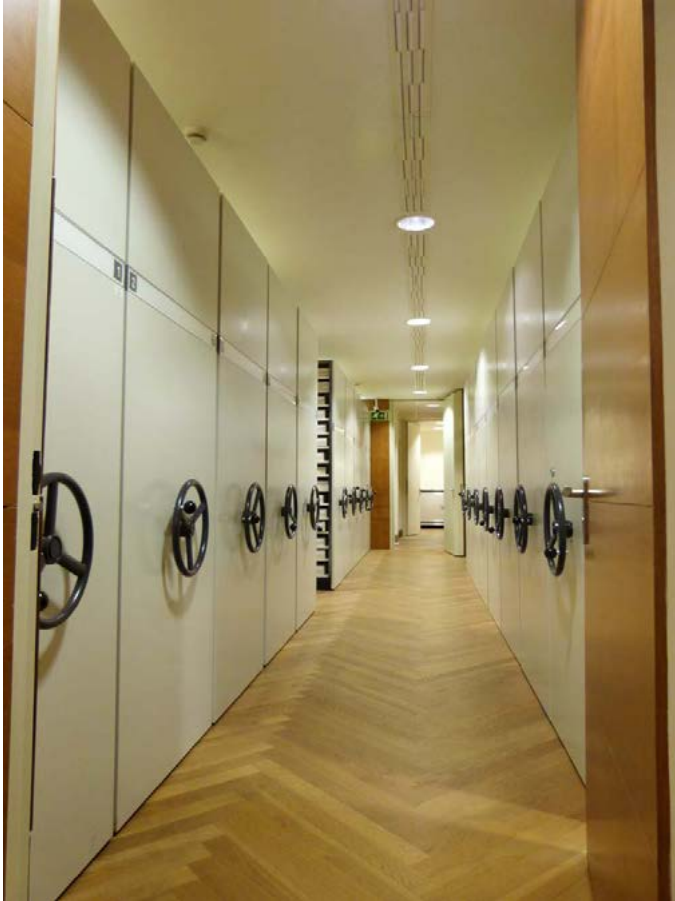
Fig. 4. Sistema de almacenamiento móvil de alta densidad «compactos», para obras de la colección de dibujos y estampas. Edificio Jerónimos. [Foto de la autora, 2015]
