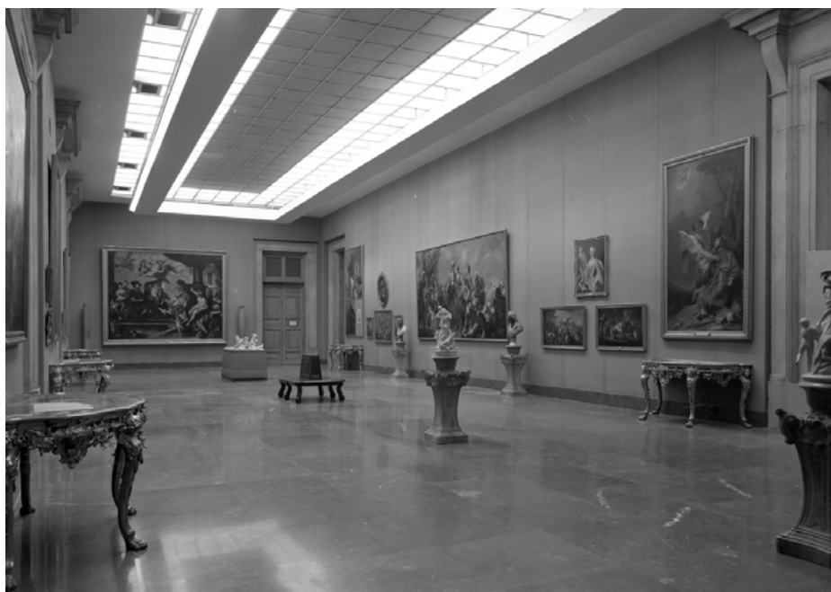
Fig. 4. Fotografía de octubre de 1976 que muestra el sistema de iluminación inspirado en el del Metropolitan Museum de Nueva York en la sala 16 B. En el lateral izquierdo del techo se observan, oscuras y discontinuas, las bocas de aspiración de aire caliente.
