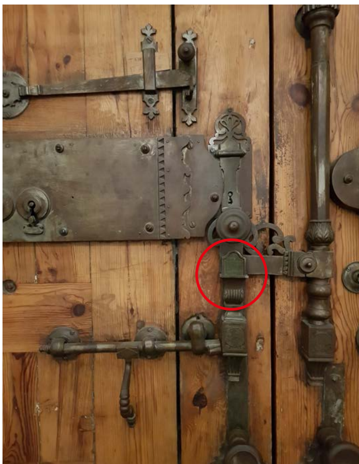
Fig. 2. Cerradura del acceso principal (interior de la puerta de Goya alta) con pequeña cartela en el centro en la que se menciona al rey Fernando VII y a su esposa Isabel de Braganza. Se instaló unos meses antes de la muerte de esta última, coincidiendo, probablemente, con la entrada de los primeros cuadros en el edificio [foto de la autora, 2019]
