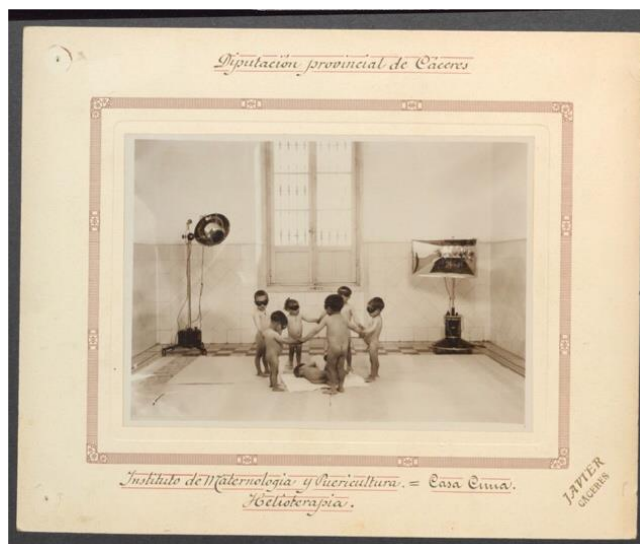
Fig. 1 Sala de Helioterapia de la Casa Cuna
