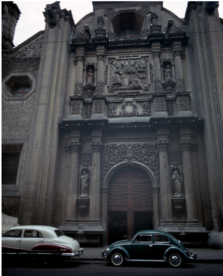
Fig. 5. Fachada Oriente de la iglesia de "La Profesa", D. F. Foto: IIE, UNAM.
